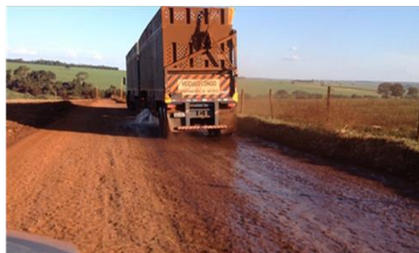
Figura 03. Aplicação de água em estradas canavieiras não pavimentadas com caminhão pipa (A) e com o equipamento barriga d'água (B).
