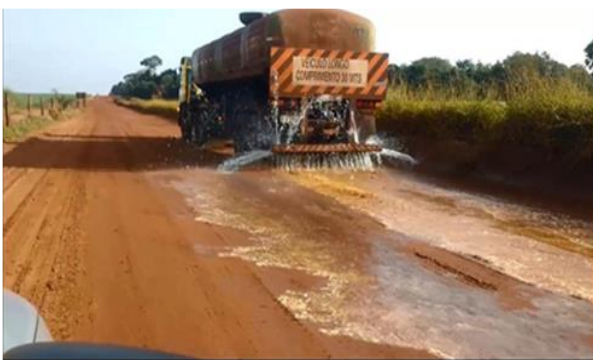
Figura 03. Aplicação de água em estradas canavieiras não pavimentadas com caminhão pipa (A) e com o equipamento barriga d'água (B).
