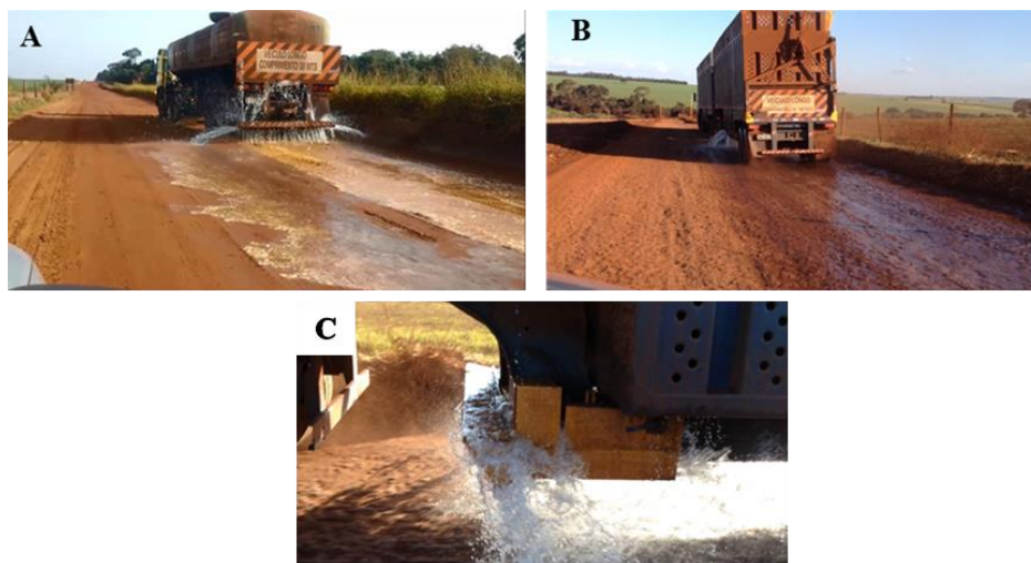
Figura 05. Aplicação de água residuária em estradas não pavimentadas com caminhão pipa (A); equipamento barriga d'água (B); e detalhe de aplicação através de canaleta (C)
